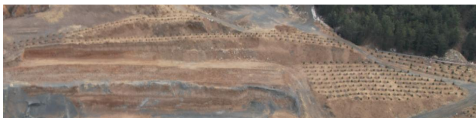
照片2-1 工业场地1治理效果照片
