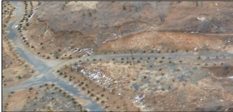
照片 4-4 矿区道路
