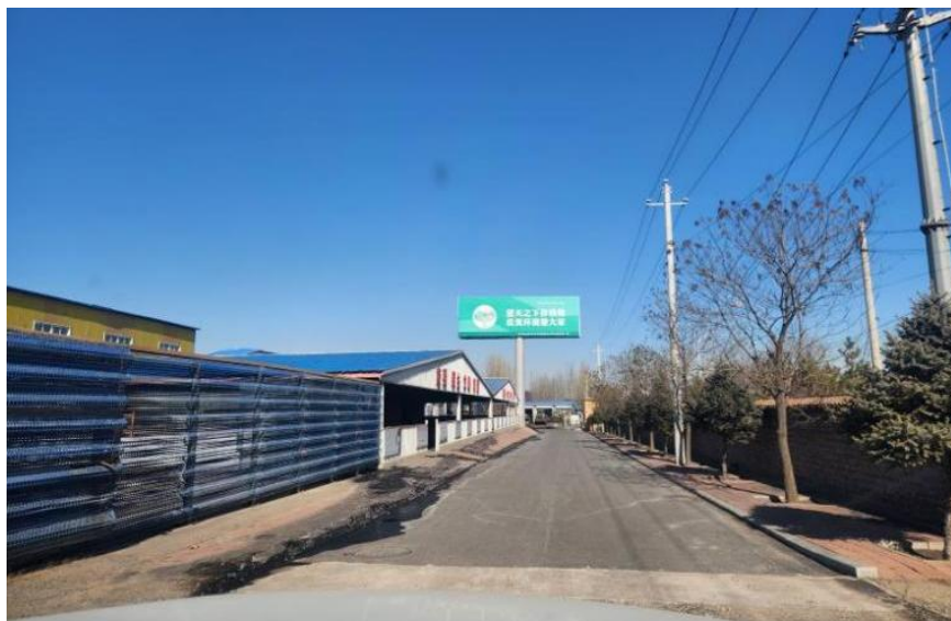
照片 1-6 矿区道路
