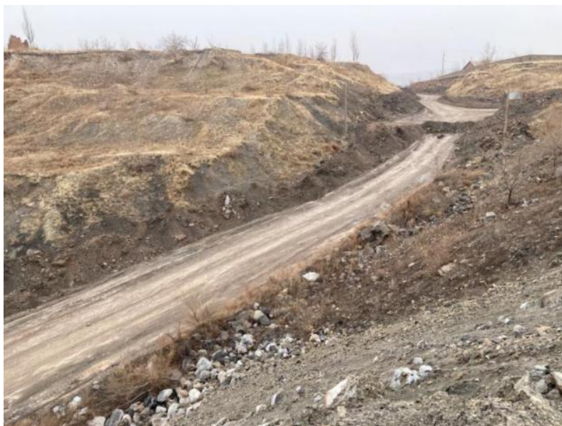
照片 4-7 矿区道路
