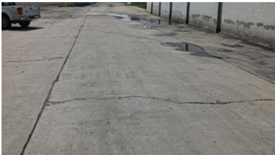
照片1-7 矿区道路
