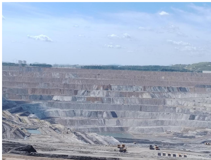
图 4-4 内排土场边坡
