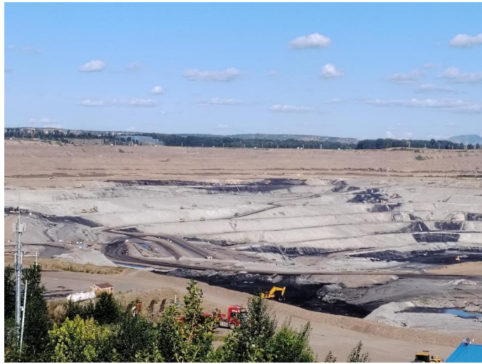
图 4-1 露天采场北部边坡
