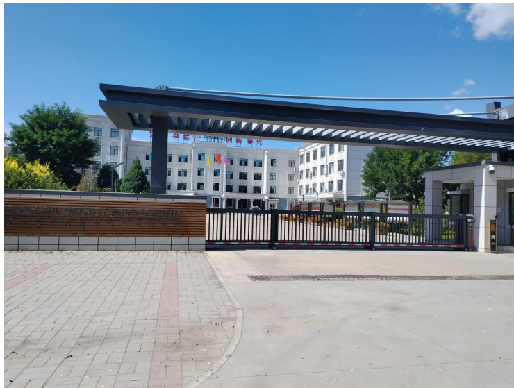
图 4-11 综合办公生活区
