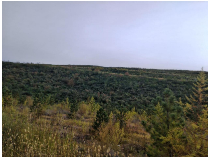
图 4-5 南排土场边坡
