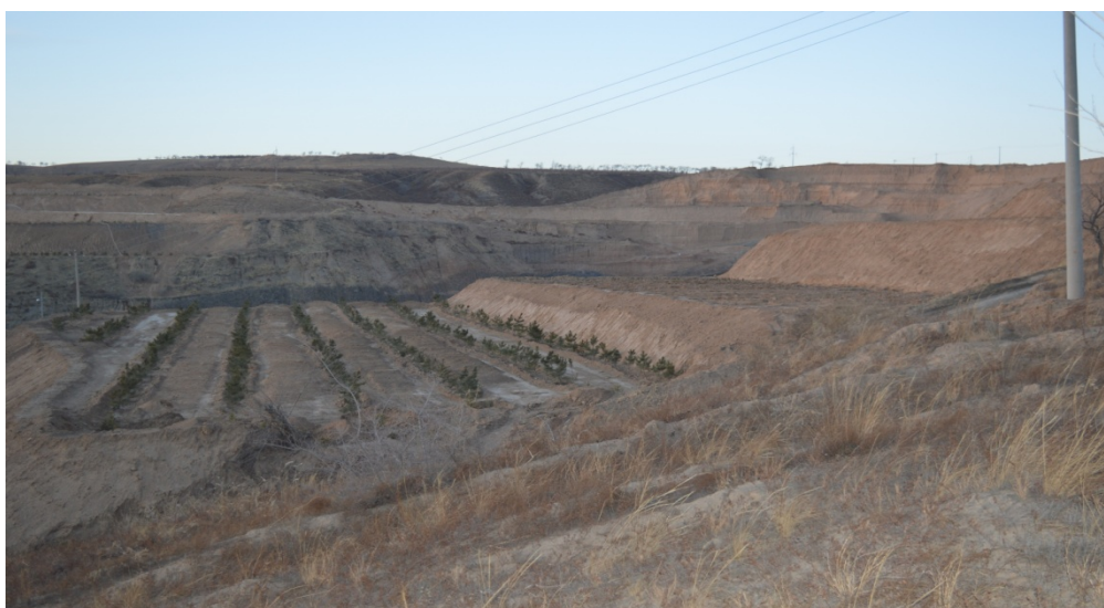
照片 2-4 废弃宿舍拆除清运、垫坡、整平、翻耕、种树
