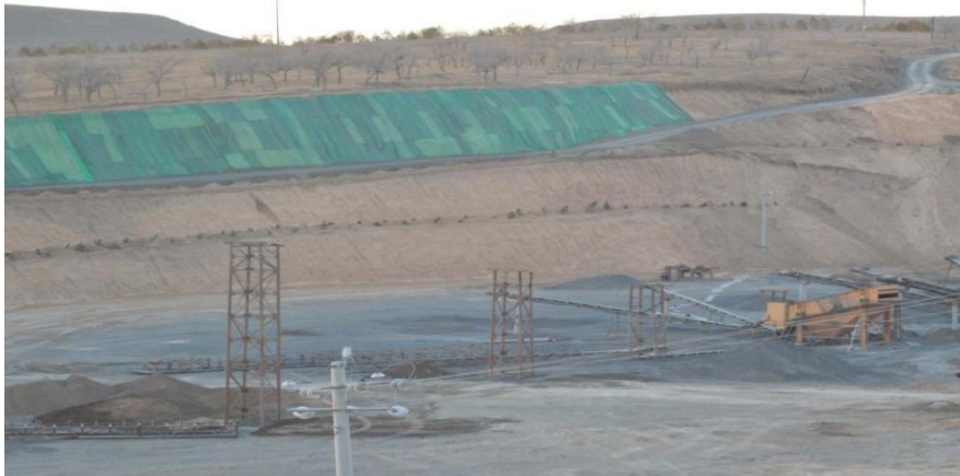
照片 3-3 采场北西进行削坡、挂网
