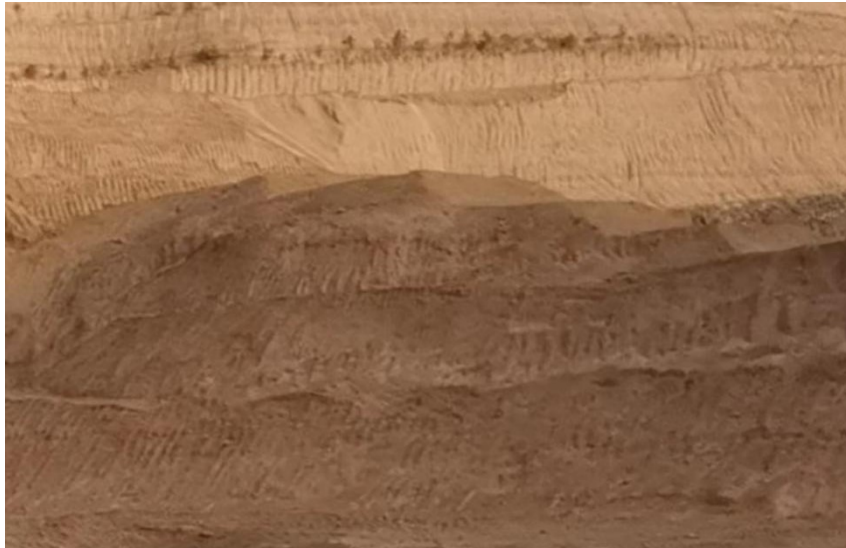
照片 2-10 露天采场垫坡治理效果
