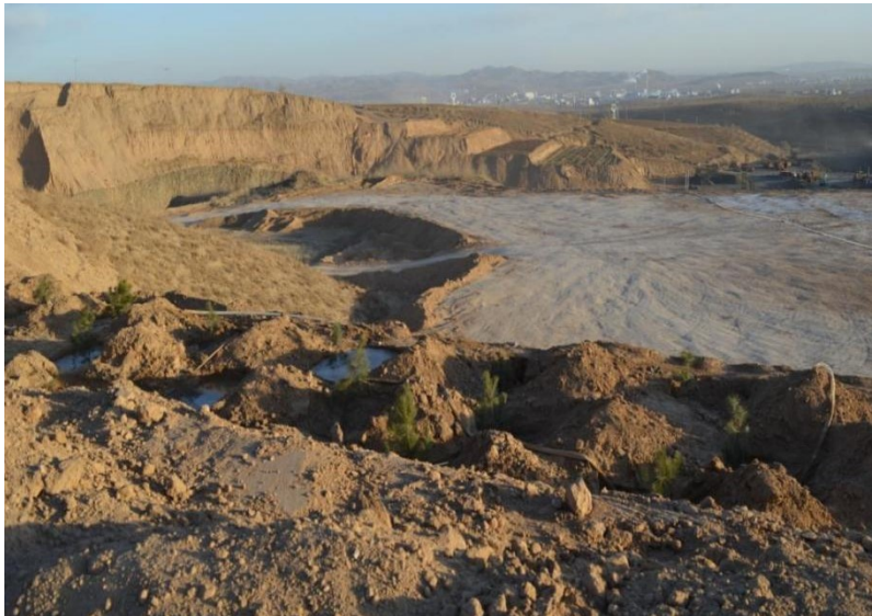
照片 2-1 采场北西处碎石加工场 2 石方整理、覆土整平、种树
