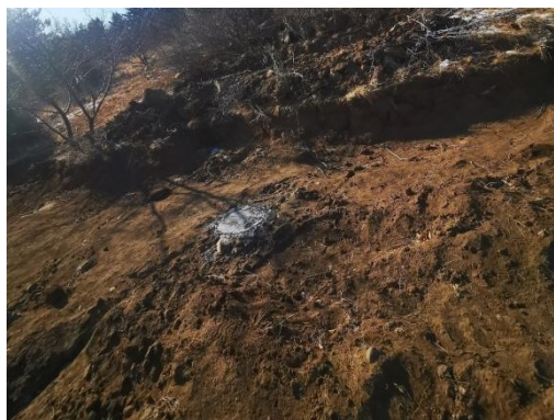
照片 4-10 钻机平台 1
