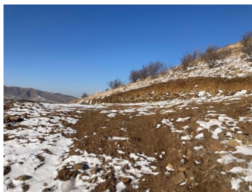
照片 4-13 钻机平台 4
