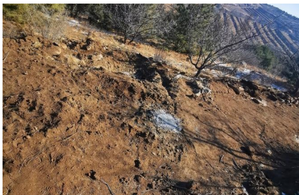
照片 4-11 钻机平台 2
