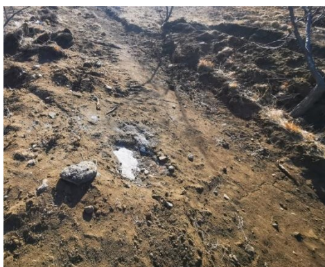
照片 4-12 钻机平台 3
