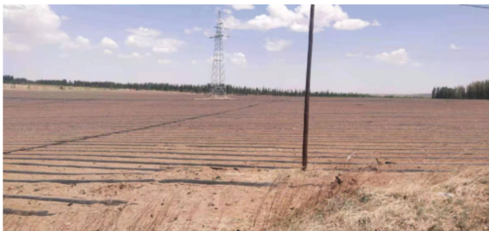
照片 2-4 地面塌陷区地裂缝回填
