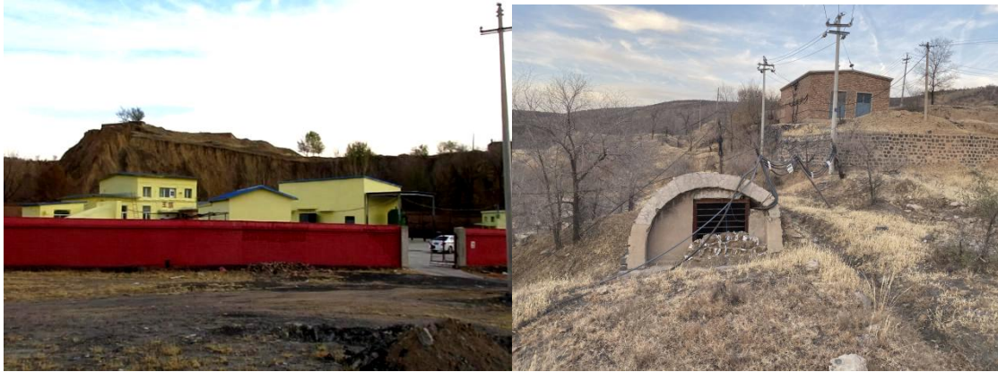
照片 4-3 工业场地 3 和工业场地 4
