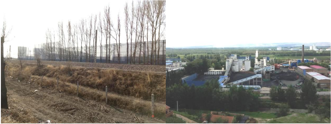
照片 4-2 工业场地 1 和工业场地 2
