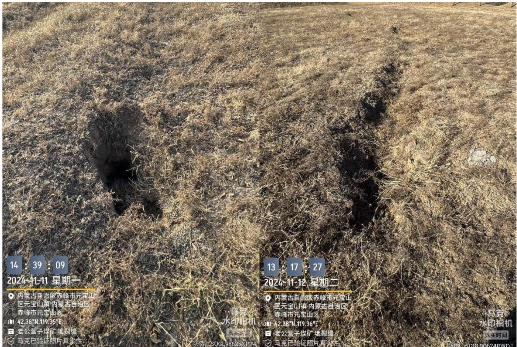
图 3.2-2 现状存在的地裂缝
