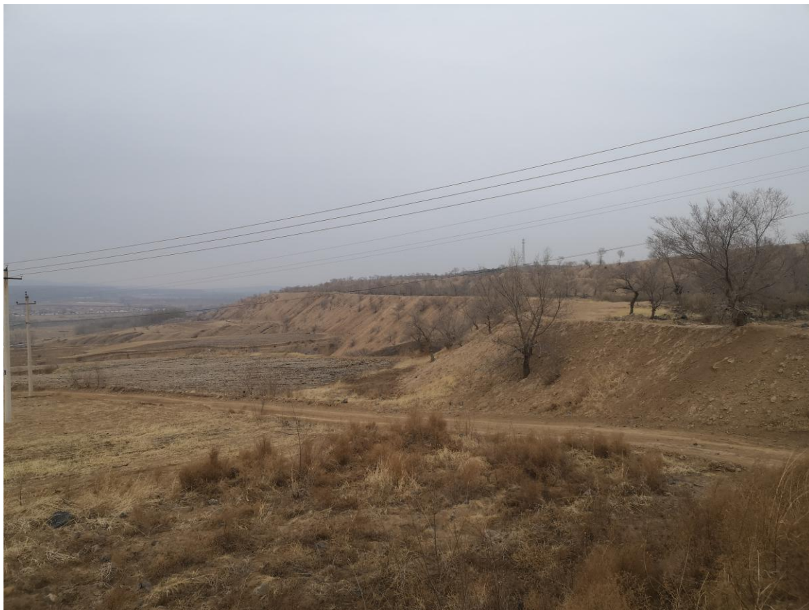
照片4-3 已治理的山后排土场
