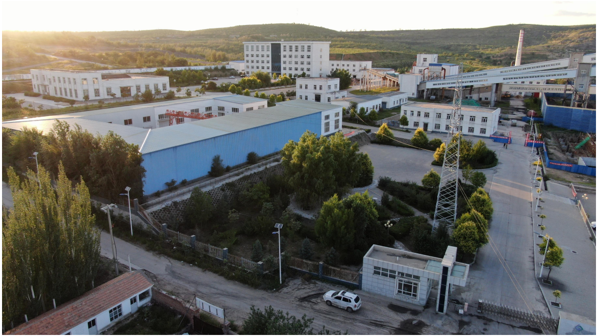
照片4-4 工业场地及办公生活区
