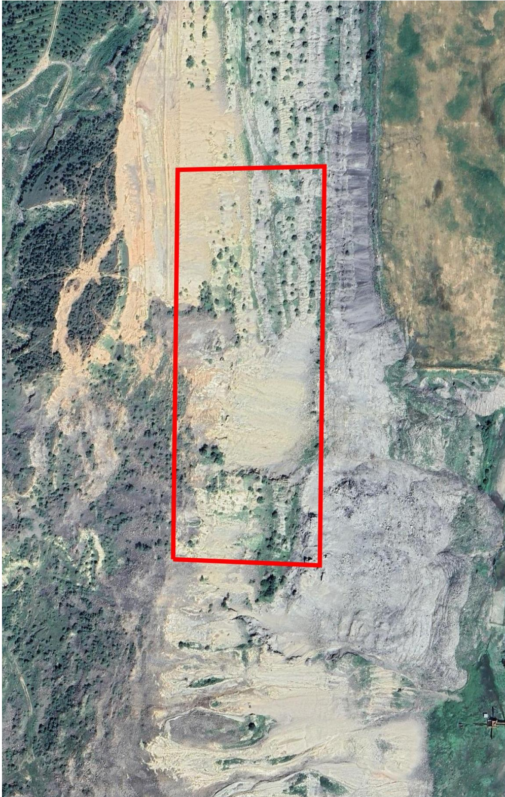
图 5-5 2026 年度治理区域影像图（预测地面塌陷区）
