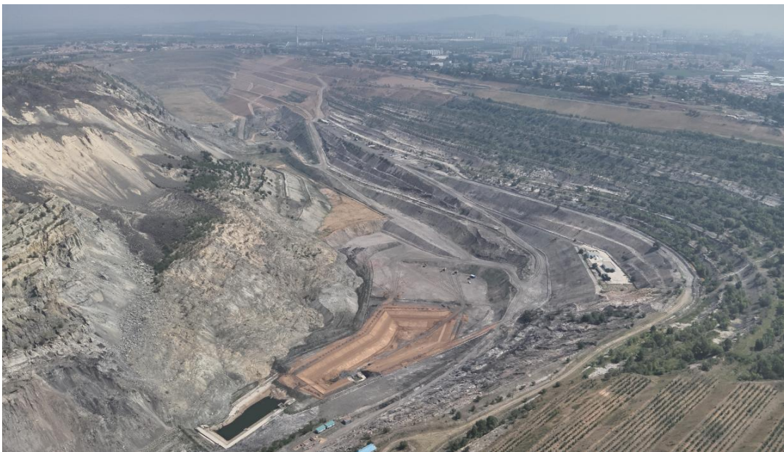
照片4-1 现状露天采场
