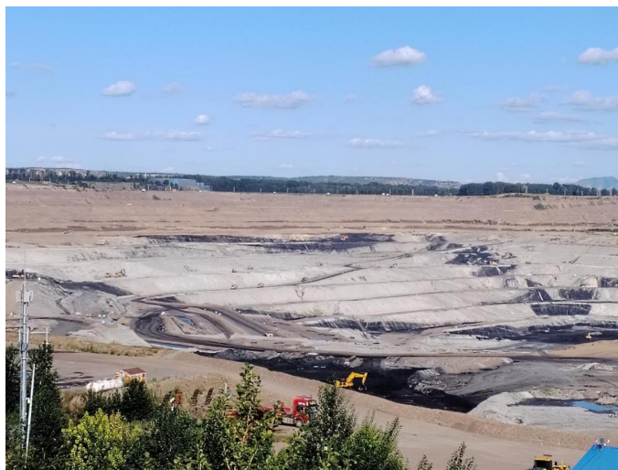
图 4-1 露天采场北部边坡
