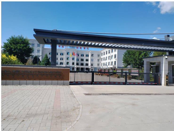
图 4-11 综合办公生活区
