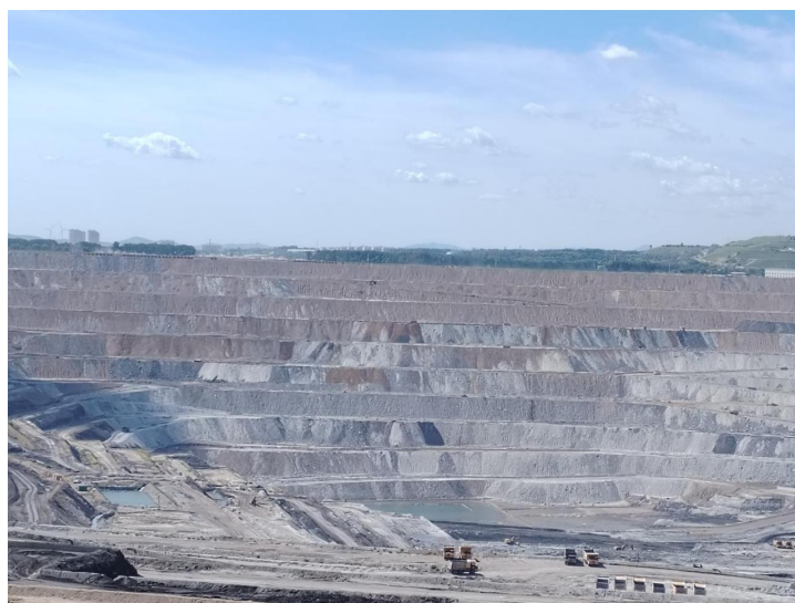
图 4-4 内排土场边坡
