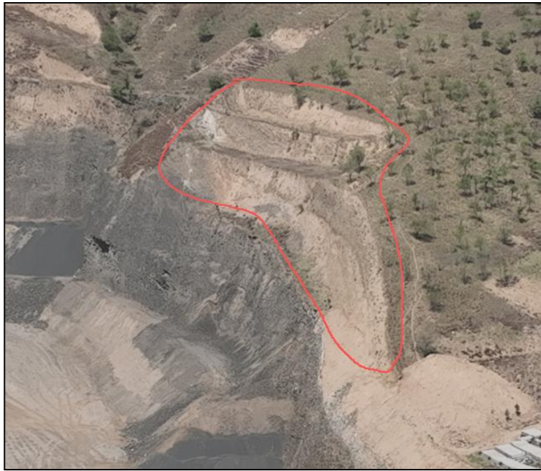
照片 3-5 表土剥离 2 区现状
