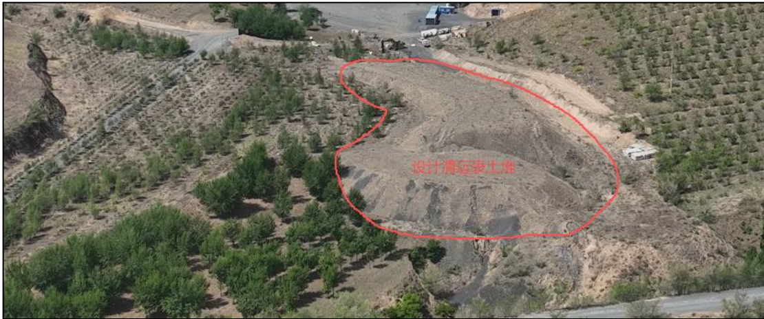
照片 3-5 矿山前期治理 1 区
