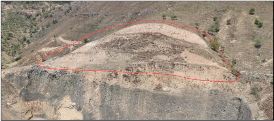
照片 3-4 表土剥离 1 区现状
